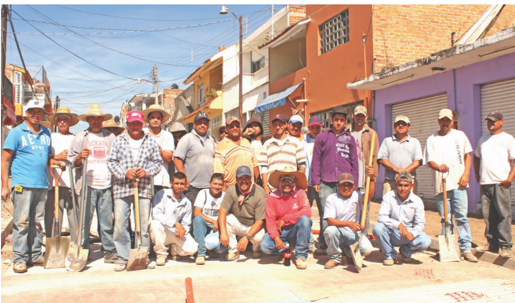
➤ En la calle Sabás Carrillo, se realiza una inversión aproximada de más de 1.3 millones de pesos, con ello se brinda empleo a 28 personas de Zapotlanejo.
