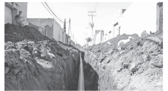
En la calle Universidad en Matatlán, se registra gran avance en la colocación de tubería nueva para el drenaje.
