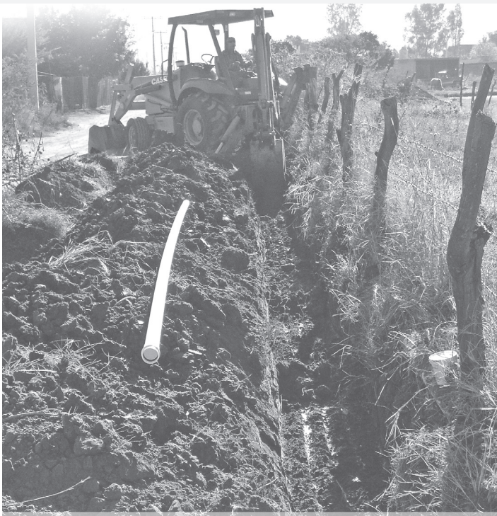
Colocación de Red de Agua Potable en Agua Blanca
