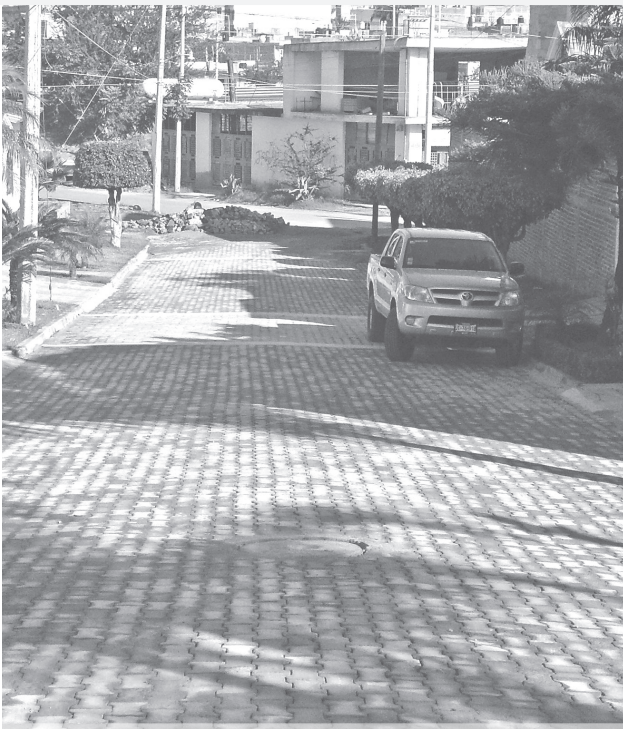
Rehabilitación de calle Violetas en Matatlán
